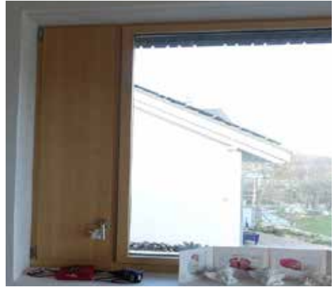
Die Fenster sind dreifachverglast, mit Flügel daneben zum Lüften. Die Wanddicke erreicht total ca. 50 cm.
