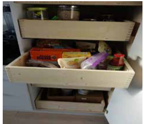
Alle Einbauschränke bestehen aus Dreischichtplatten (in der Küche sind sie lackiert) und wurden von der Schreinerei Beat Lüthi, Belpberg, geliefert und montiert.
