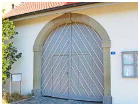
Der neu renovierte Toranbau.
