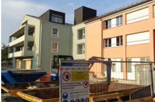
Harmonisch: Anbau mit «WmD» (links im Bild).
