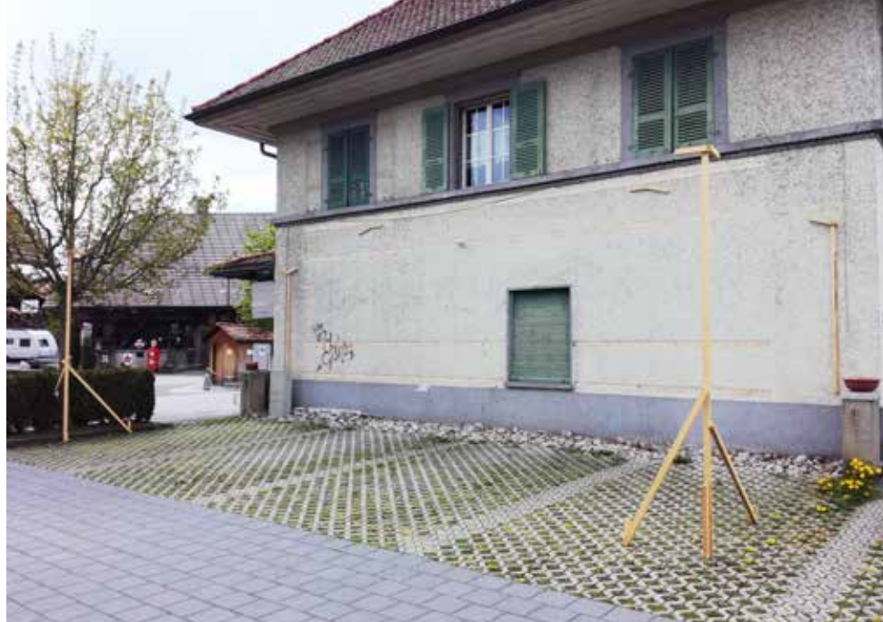
Die seit Ende April aufgestellten Profile zeigen Länge, Breite, Höhe und Dachneigung des geplanten Anbaus.
